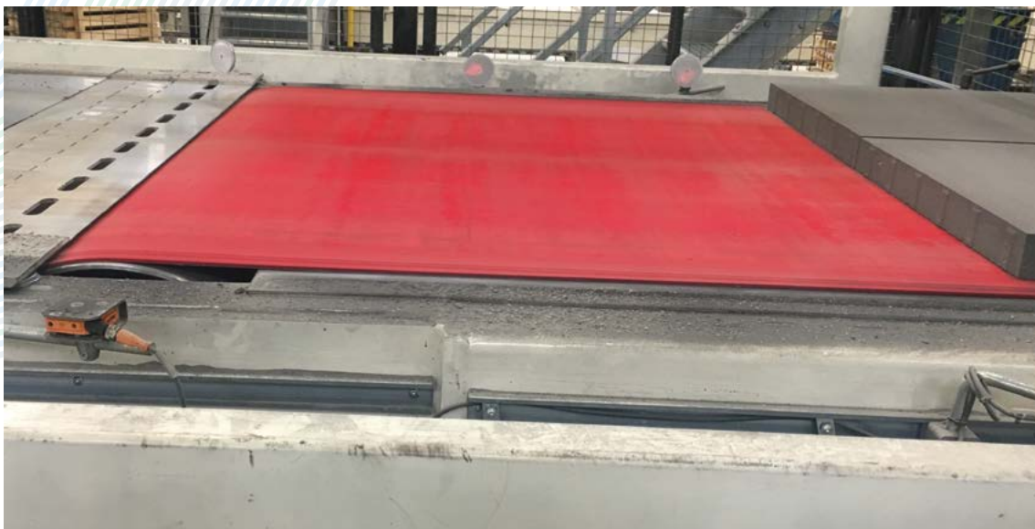
Transport de dalles de béton
